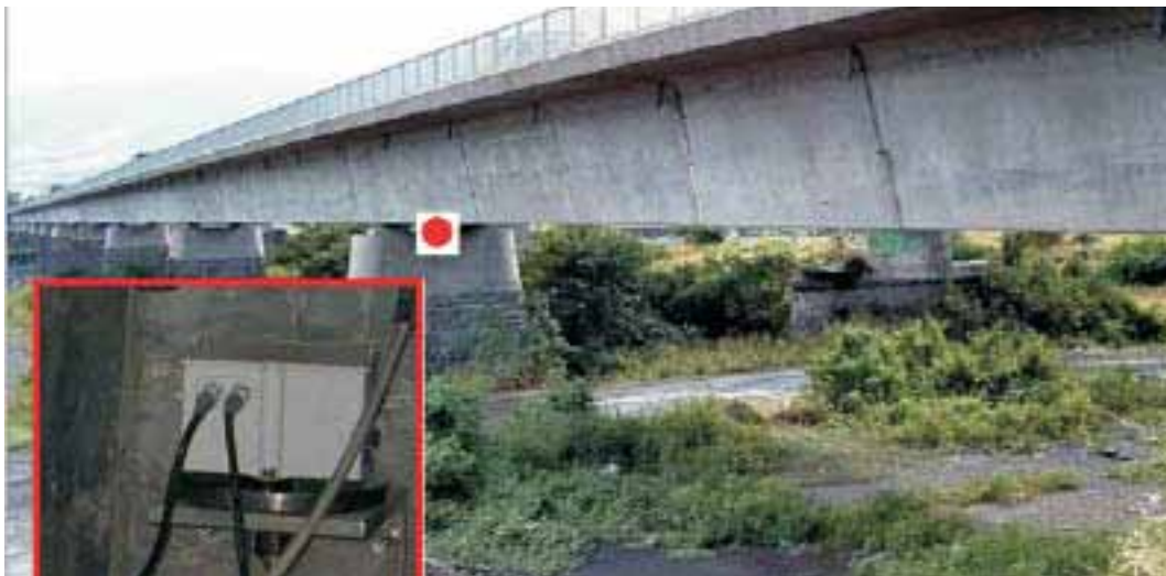
Рис.3 Пример установки инклинометра для измерения смещения (наклона) опоры моста
